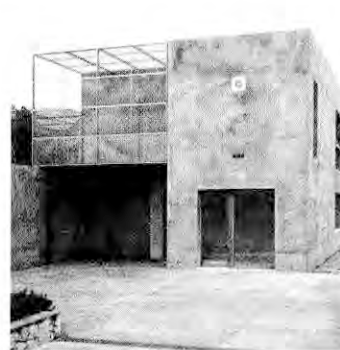
Dalle macerie. Maria Giuseppina Grasso Cannizzo: Casa Parisi Sortino, Ragusa, 2004. Non incrementando la cubatura, colmando i vuoti, e riusando macerie dalla parziale demolizione dell'edificio precedente si è ridefinito il volume complessivo. La scelta del "non colore" risponde alla logica minimamente interventista
