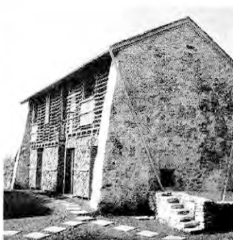
Ex rudere. Studio Albori: Casa Fienile, Ispra (Varese), 2007-2010. Del rudere agricolo sono state mantenute le strutture in pietra. Sulla facciata è stata creata un'intelaiatura in legno ombreggiante nella parte superiore, mentre in quella inferiore produce uno spazio protetto per l'accatastamento della legna che fa anche da isolante
