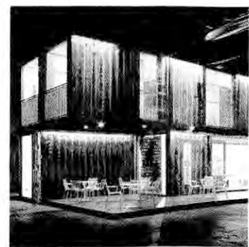
Container. AstoriDePontiAssociati: Green Frame House, prototipo, 2010. In collaborazione con la società Art Container il progetto è stato presentato alla fiera Abitare il Tempo 2010. Un sistema di sei container di riciclo per la creazione di un appartamento di 140 mq con terrazzi e patio
